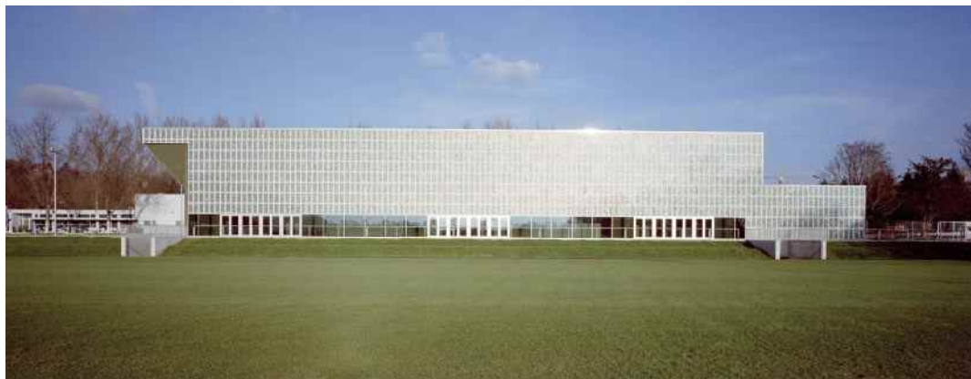
Die TÜ-Arena in Tübingen: Die weltgrößte Photovoltaikfassade mit farbigen Solarzellen kommt von Sunways.
